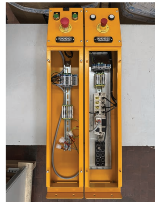
Înainte (stânga) și după (dreapta): soluția IP67 descentralizată de la Murrelektronik simplifică instalările, deoarece nu mai sunt necesare șine de conectare și conexiuni la panoul de comandă.
