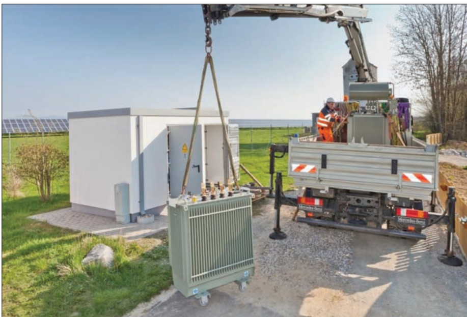
Fig. 2. Transformator de distribuție cu tensiune reglabilă
